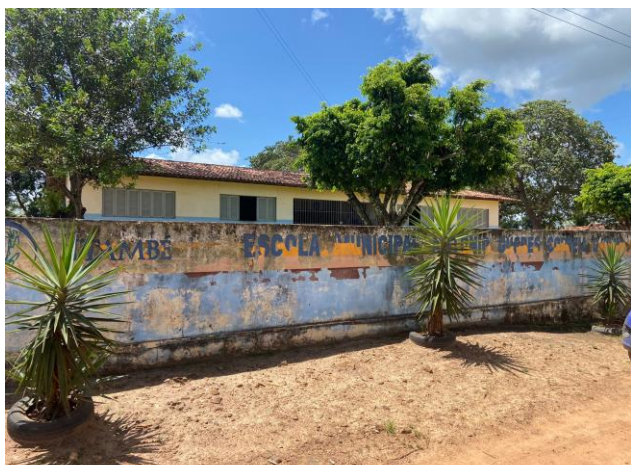
VISTA PINTURA ESCOLA
