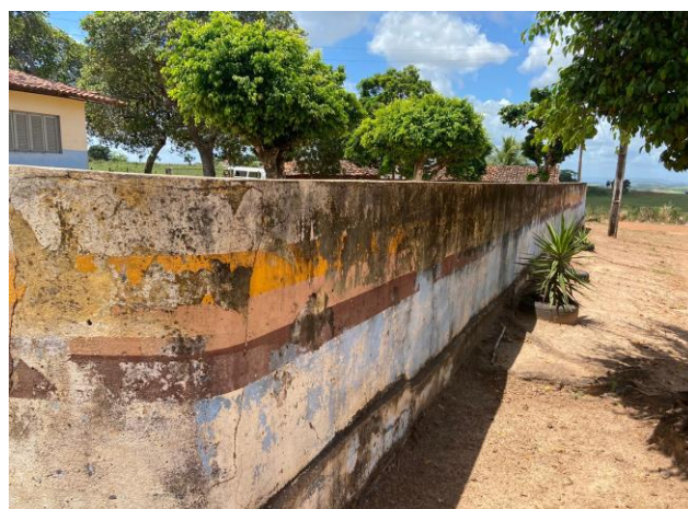
VISTA PINTURA ESCOLA
