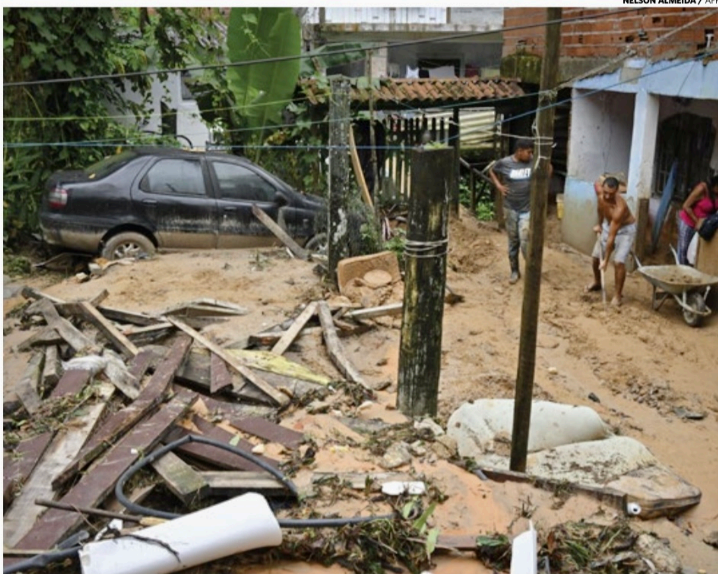
Desastre causado pela chuva em São Sebastião
